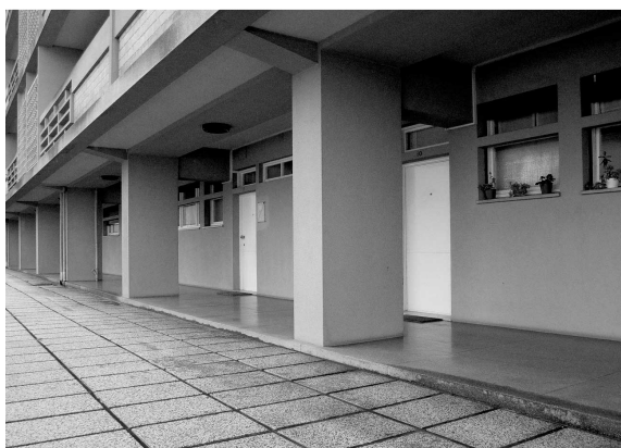
Ilustração 9 - Edifício Ouro, Porto
