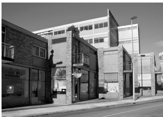
Ilustração 10 - Edifício Parnaso, Porto
