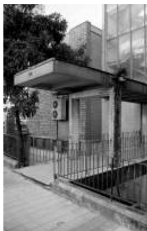
Ilustração 11 - Edifício Parnaso, Porto
