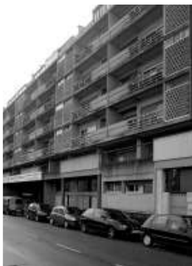
Ilustração 8 - Edifício Ouro, Porto
